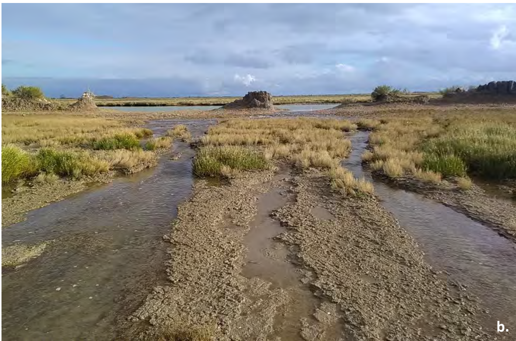
Figure 12. Photos de la brèche 2019
