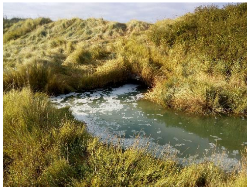
Entrée eau salée à l'intérieur du marais à marée haute : dysfonctionnement de la porte à flots (plutôt rôle de dalot) La mer remonte le long des fossés après la digue aux moines 10/09/2018 à 9h10 (coef 108 - PM à 8h27)
