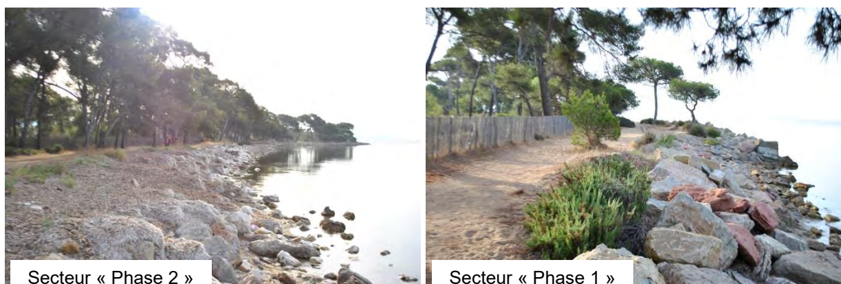
Fig. 1. Photographies des enrochements actuels
