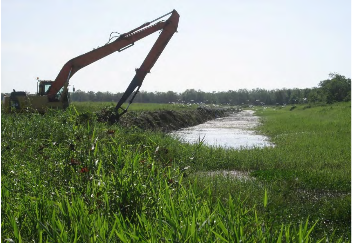
Figure 4 : Curage mécanisé du grand canal, juillet 2016
