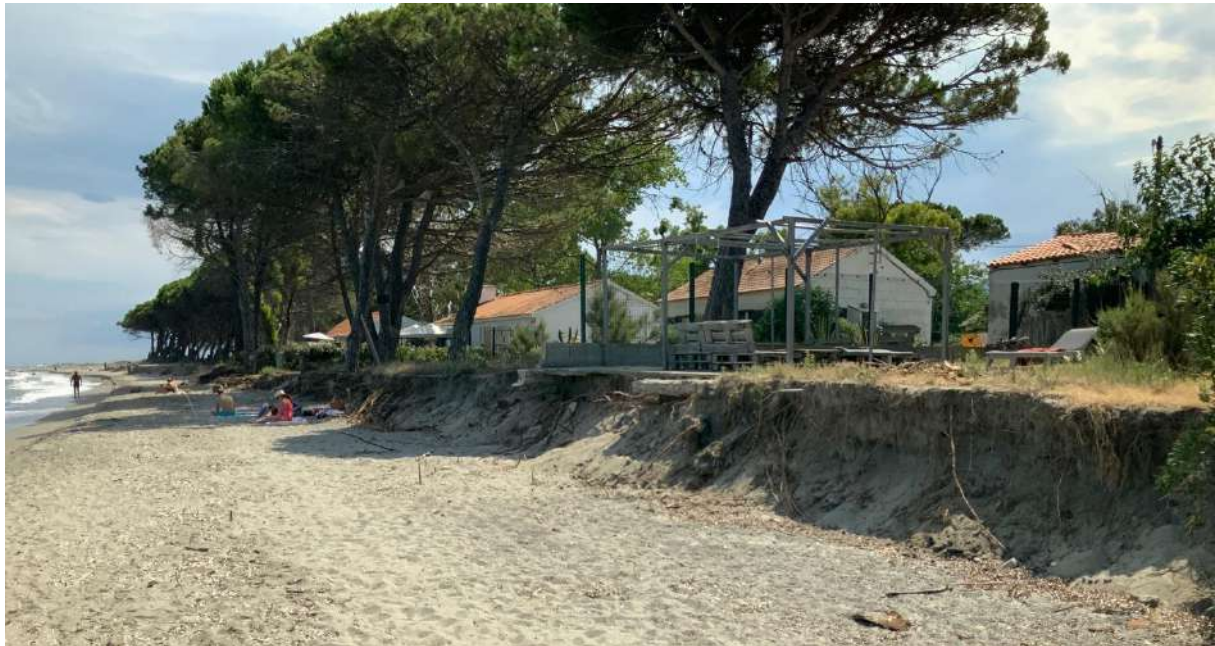
Figure 1 : À Tanghiccìa, plusieurs maisons sont situées directement sur le cordon dunaire, en érosion rapide sur ce secteur
